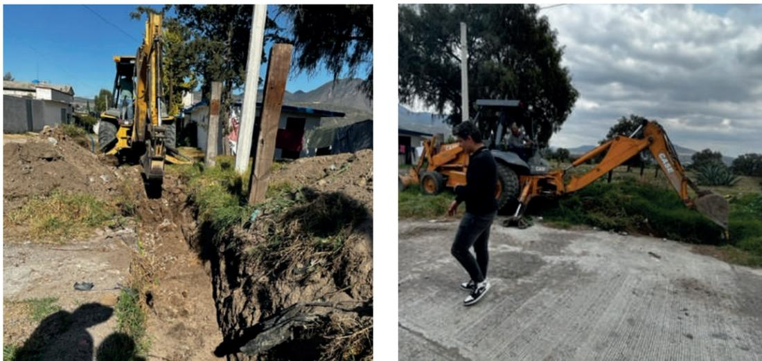
**Obra 6: Construcción de drenaje pluvial**
