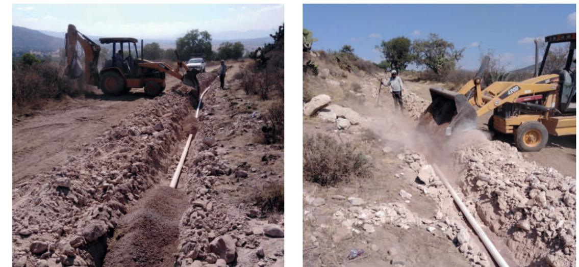
**Obra 4: Rehabilitación de sistema de agua entubada**
