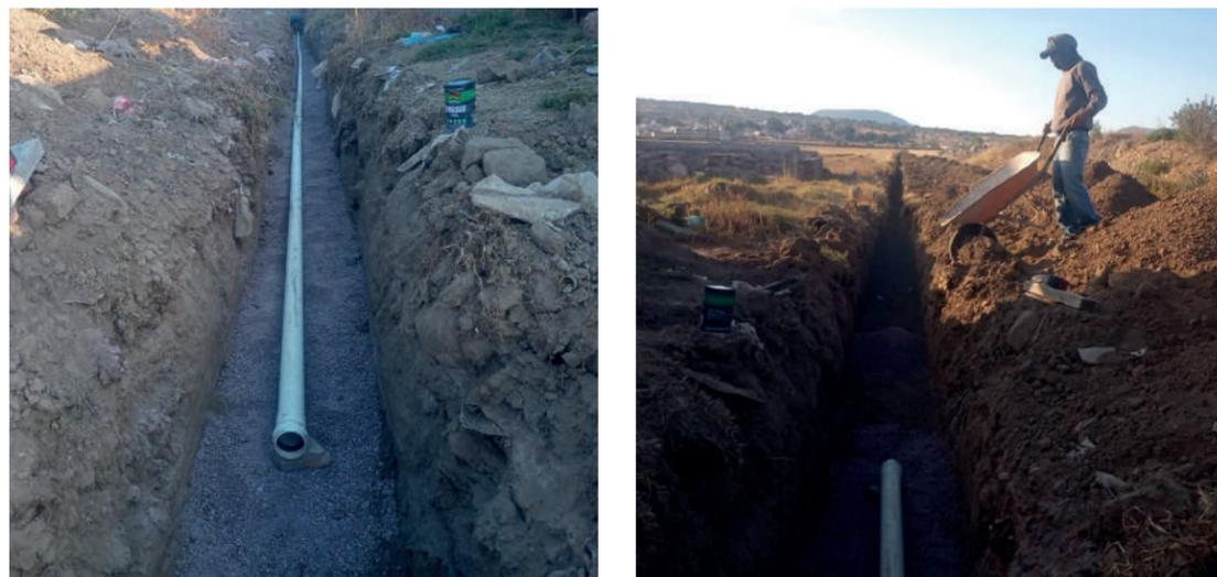
**Obra 10: Rehabilitación de sistema de agua entubada**
